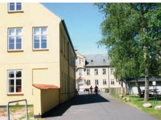
Bygningerne er gamle og velholdte. En fornøjelse af færdes i.
